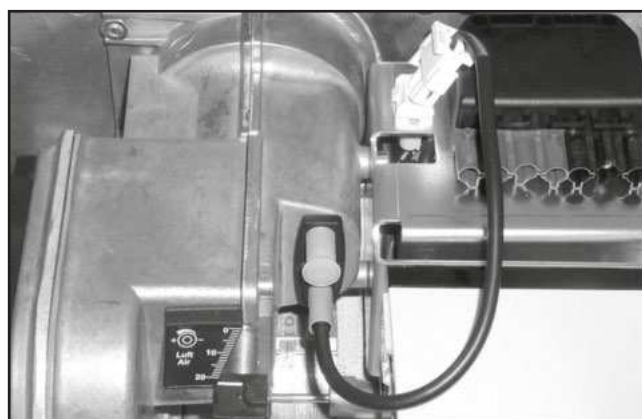
Afbeelding 29 — Stekkeraansluiting voor vlamcontrole cel
