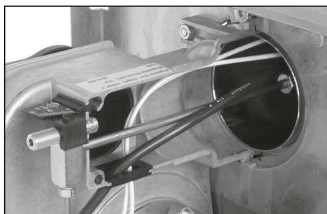
Afbeelding 27 — Demontage van de verstuur afdek plaat
