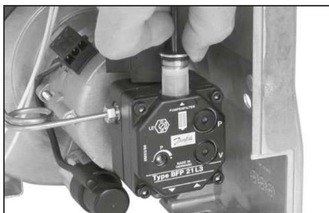
Afbeelding 25 — Oliefilter uithalen
